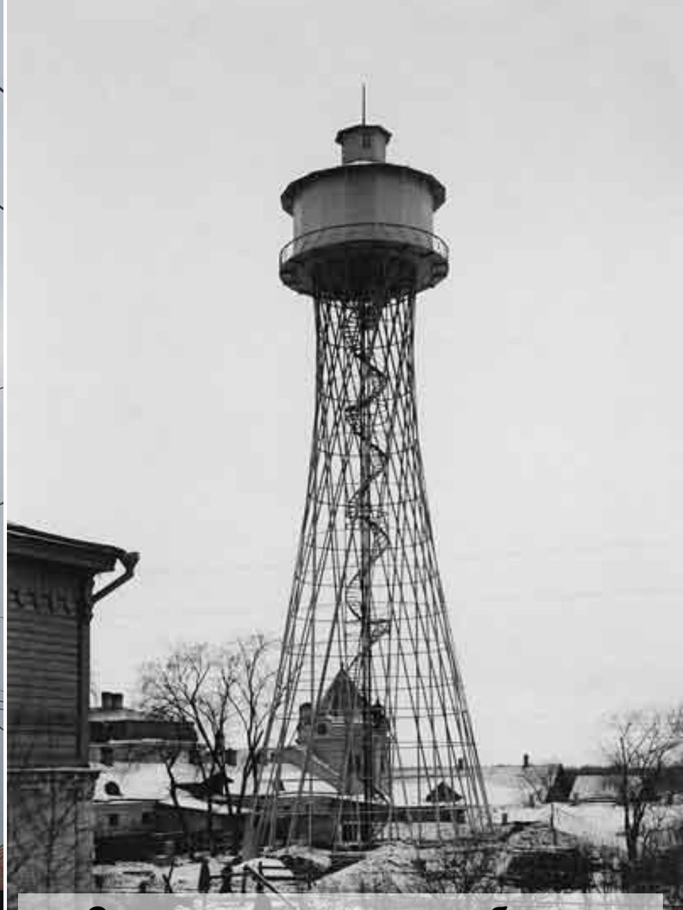
Сетчатая водонапорная башня в Петровско-Разумовском, 1914 г.
