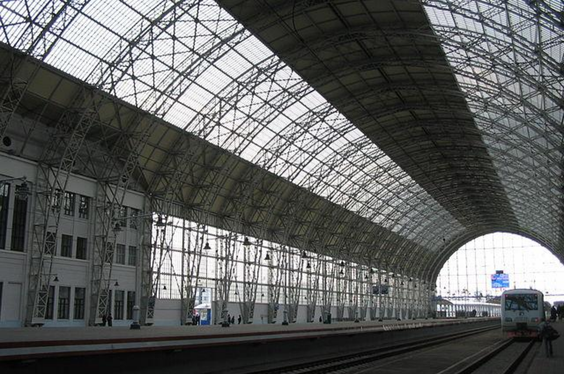
Шуховский металло-стеклянный дебаркадер Киевского вокзала в Москве
