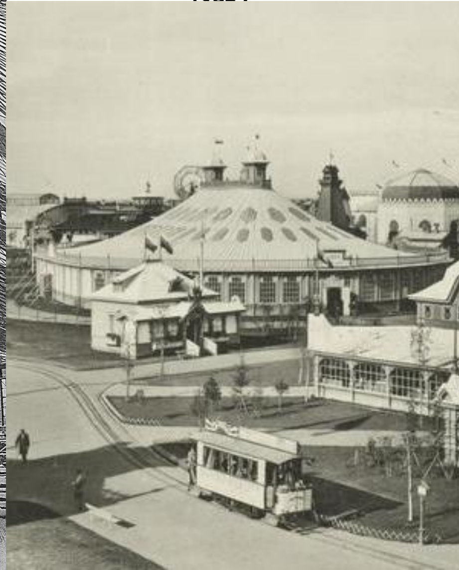
Строительство овального павильона с сетчатым стальным висячим покрытием для Всероссийской выставки 1896 г
