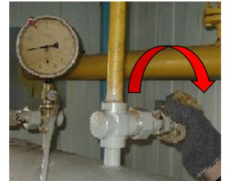
**Если стрелка манометра на ГЦ вернулась в исходное положение менее чем за 3 сек. то - ПСМ неисправен**
