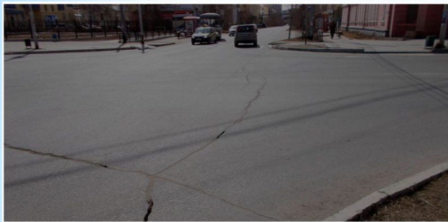
Морозобойные трещины
