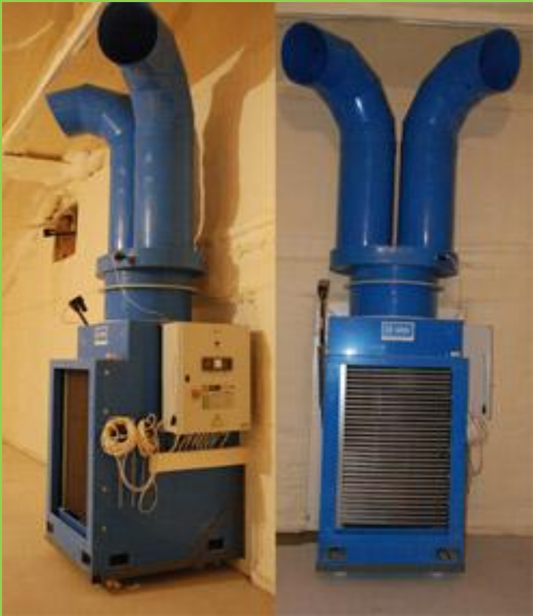
Камера смешивания воздуха – впускные и выпускные заслонки и вентиляторы Выпускные заслонки и элементы управления (радиальный электрический активатор и зубчатые рейки).
