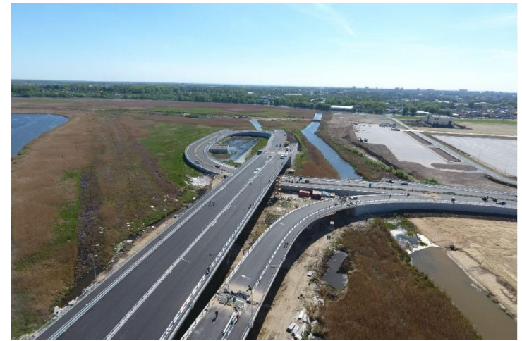
Інженерна споруда Естакада Транспортна
