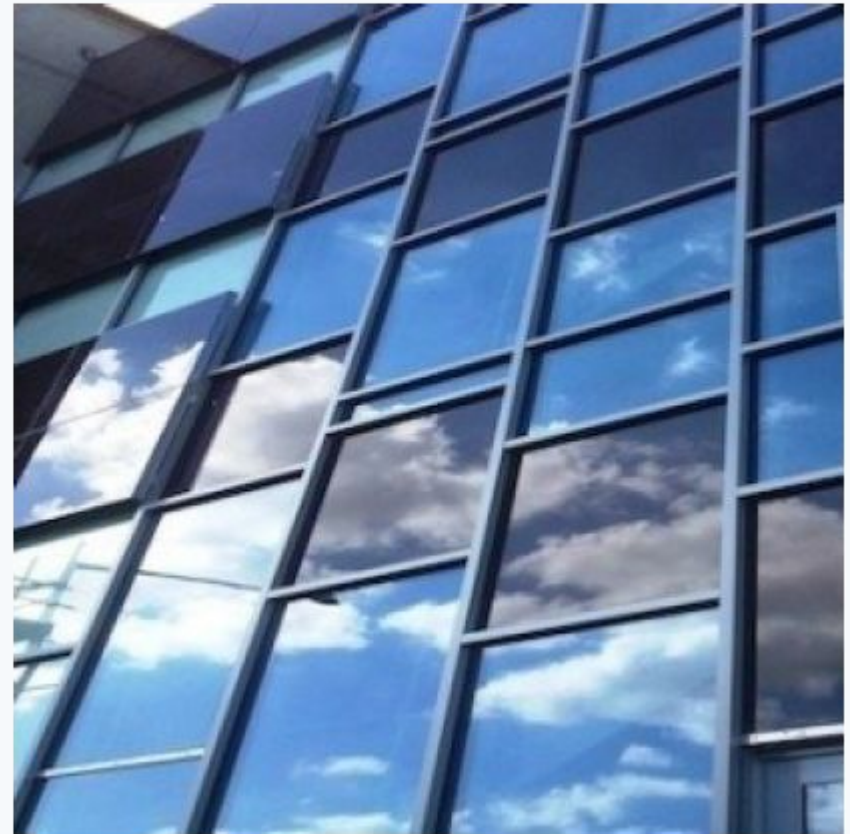
Здание Бизнеса-центра в Кембридже. Сочетание тонкопленочных РV-модулей и обычного остекления
