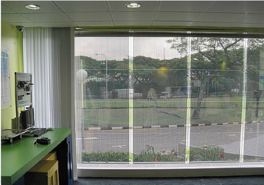
ВРV-остекление, использованы тонкопленочные модули большой прозрачности
