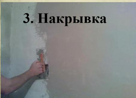
Служит для окончательного выравнивания и заглаживания поверхности при устройстве улучшенной и высококачественной штукатурке. **Толщина слоя 3 мм.**
