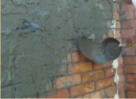
Предназначен для соединения штукатурки с основанием путем заполнения пустот и трещин. Обрызг выполняют раствором жидкой консистенции. Обрызг предаёт поверхности шероховатость. **Толщина слоя - 5 мм, на деревянные поверхности — не более 9-10 мм.**
