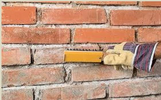
Сложенные в пустошовку и имеющие достаточную шероховатость, очищают металлической щеткой и смачивают водой. Если швы кладки заполнены раствором полностью, их выбирают на глубину не менее 10 мм.
