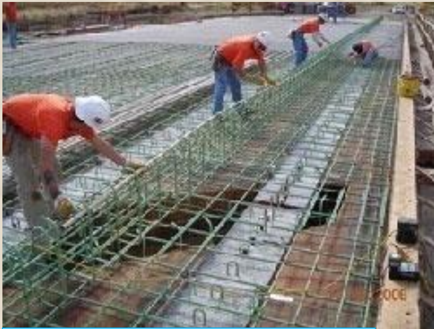
настилы и ограждения мостов
