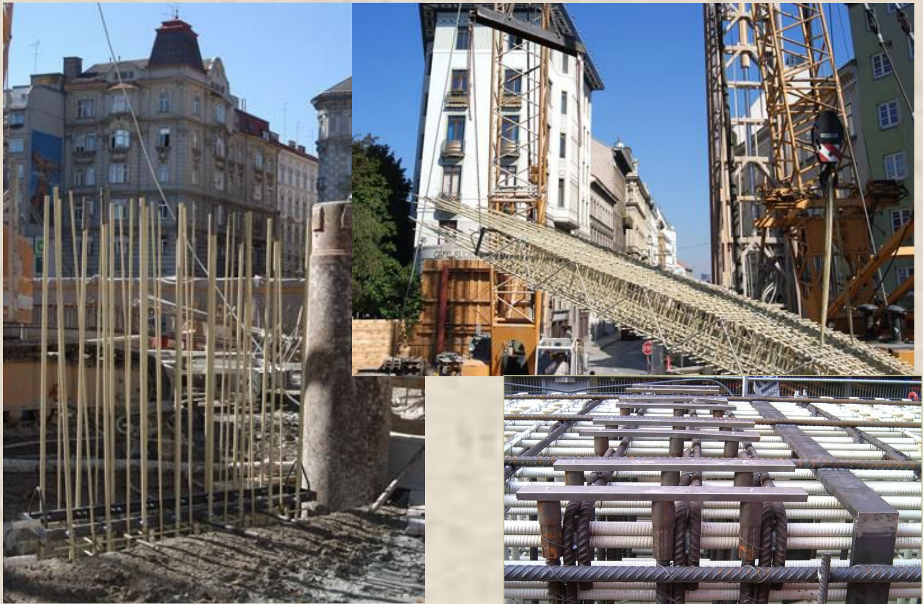
Подземное строительство Коллектор WSK-E Вена, Австрия. 2004
