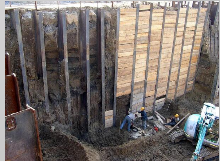
Схема крепления котлована с помощью двутавровых балок
