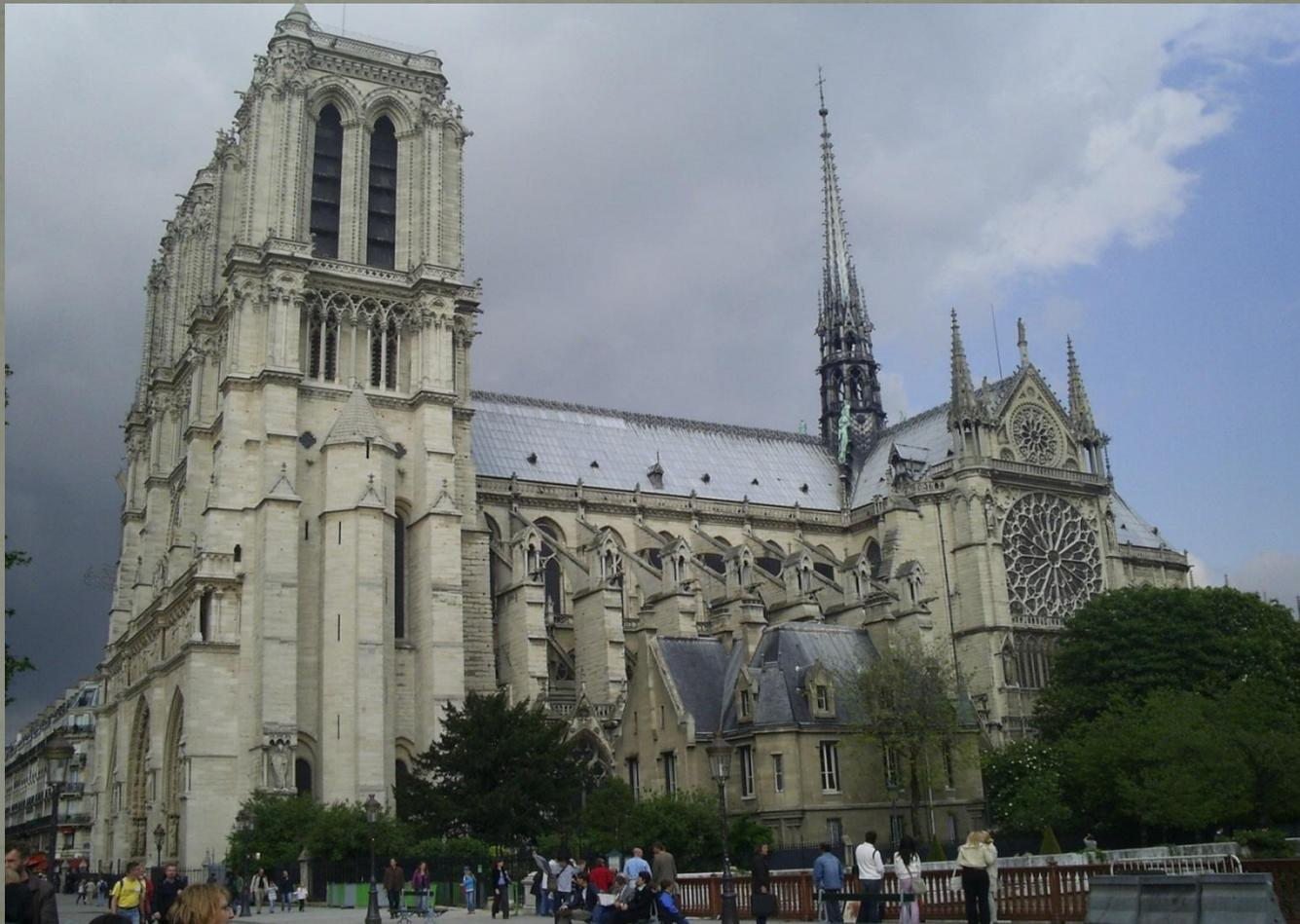
**Контрфо́рс** — вертикальная конструкция, представляющая собой либо выступающую часть стены, вертикальное ребро, либо отдельно стоящую опору, связанную со стеной аркбутаном.
