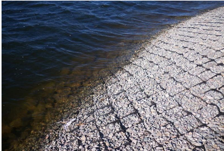
Земляные работы по укреплению берега габионами с отсыпкой гравием
