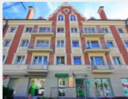
Квартира в доме на Ленинском
