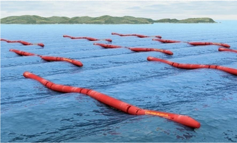
Толқын ЭС Pelamis P-750, Португалия (1 конвертор 750 КВт)
