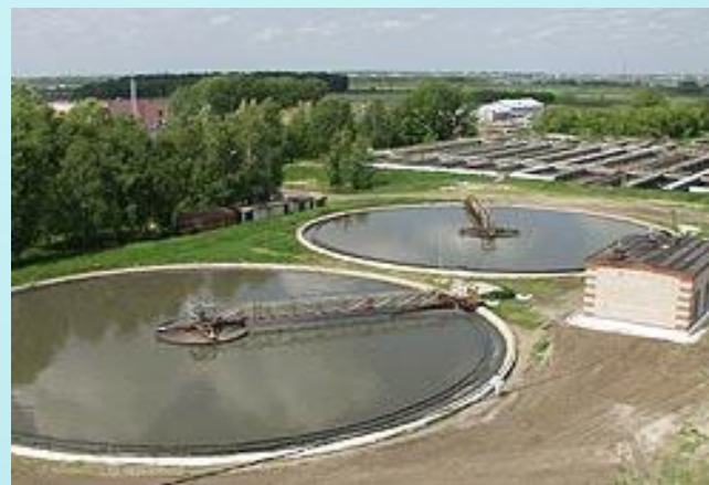
Вертикальный и радиальный отстойники
