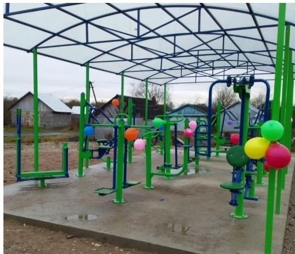
Установка уличных тренажеров в д.Новое Овсино
