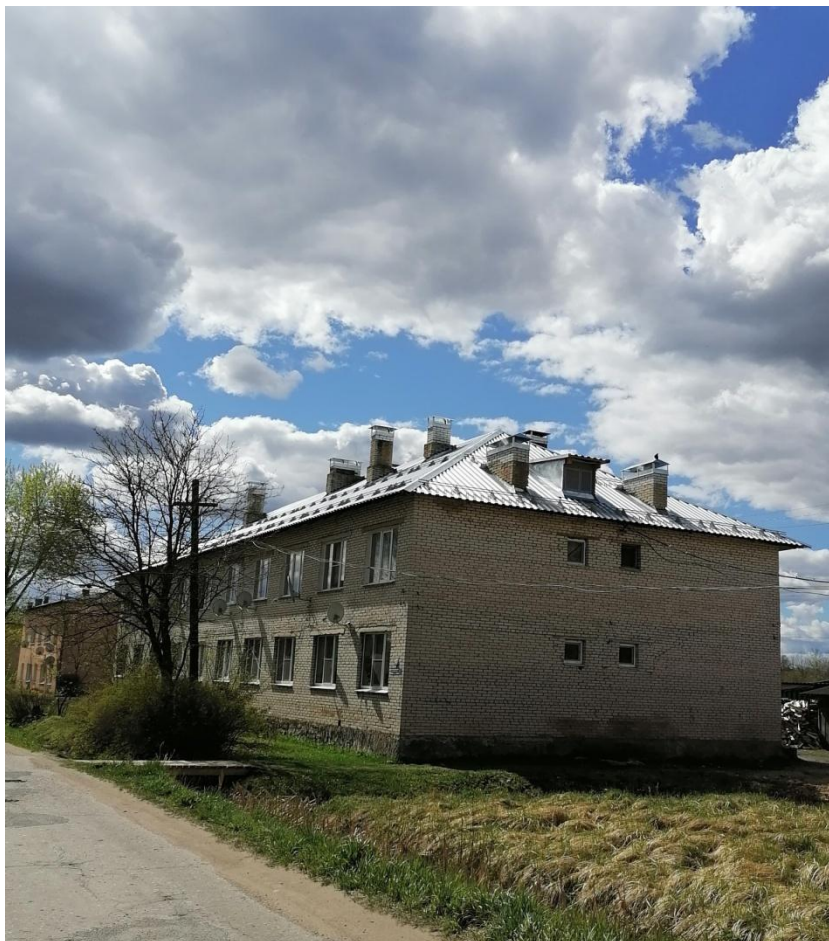
Ремонт кровли дома № 17 по ул.Комарова в п.Батецкий
