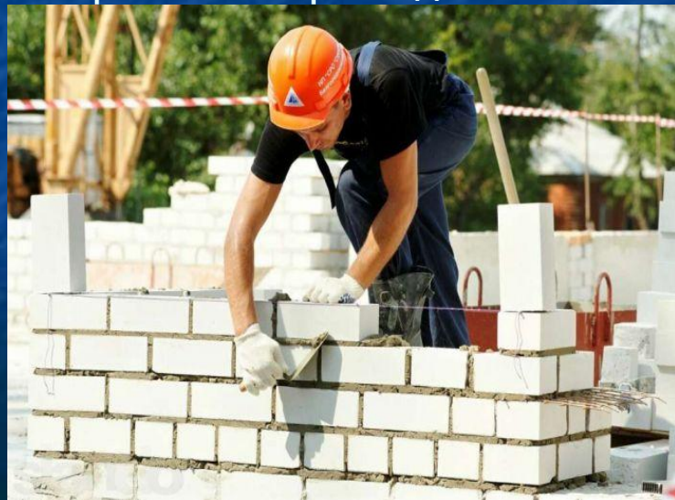
7. Строитель строит дом
