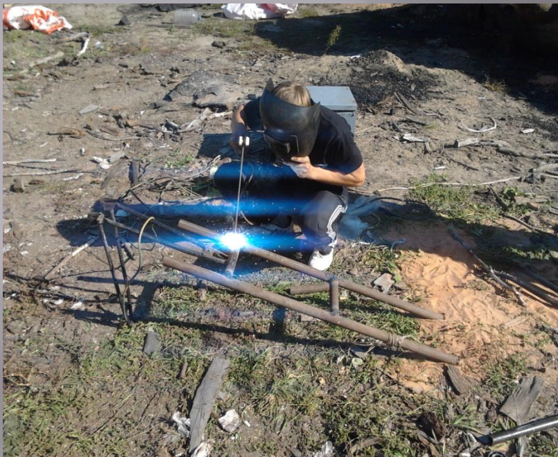
Сварочные работы выполняет студент 3 курса Гуськов Александр
