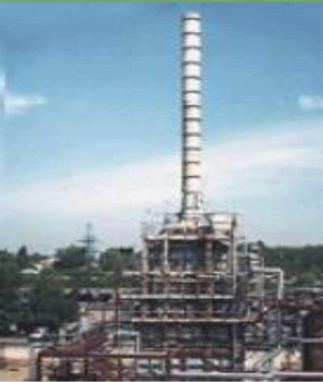
Трубчатые печи (ТП) предназначены для **высокотемпературного** нагрева углеводородного сырья. Нагрев нефтепродуктов в ТП связан с излучением тепла от нагретых газов к стенке трубы, передачей тепла теплопроводностью через стенку трубы и вынужденной конвекцией внутри трубы. В трубчатых печах (ТП) нагреваемое сырье движется в трубах змеевика, а горячие продукты сгорания омывают трубы снаружи
