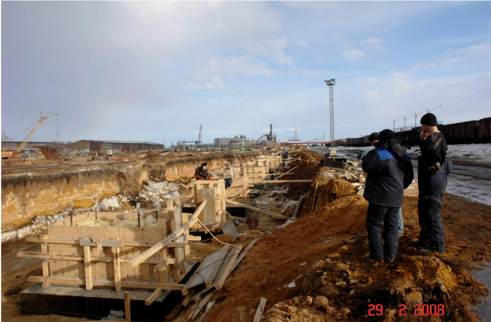
**Первый поток** - монтаж колонн в стакан фундамента осуществляется по рядам. Монтаж колонн выполняется с предварительной раскладкой или "с колес".
