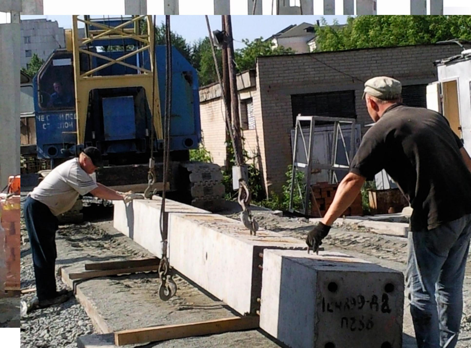
Легкие колонны монтируют способом поворота, поэтому их укладывают нижним краем к стакану, тяжелые колонны устанавливают методом поворота со скольжением на неизменном вылете стрелы крана, поэтому их укладывают верхним краем к колонне.
