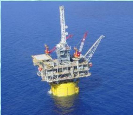
Мачтовой называют платформу, которая представляет конструкцию в виде одной стойки (или колонны), на верху которой закрепляется верхнее строение, низ стойки опирается на фундамент, а вся конструкция удерживается от опрокидывания с помощью оттяжек, закрепляемых на дне моря в количестве и местах, определяемых расчетом.
