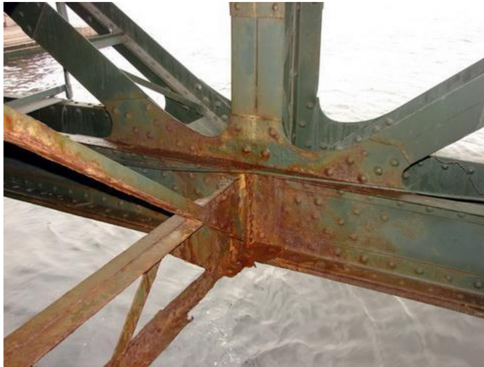
Рис. 1.7 – Коррозионное поражение
