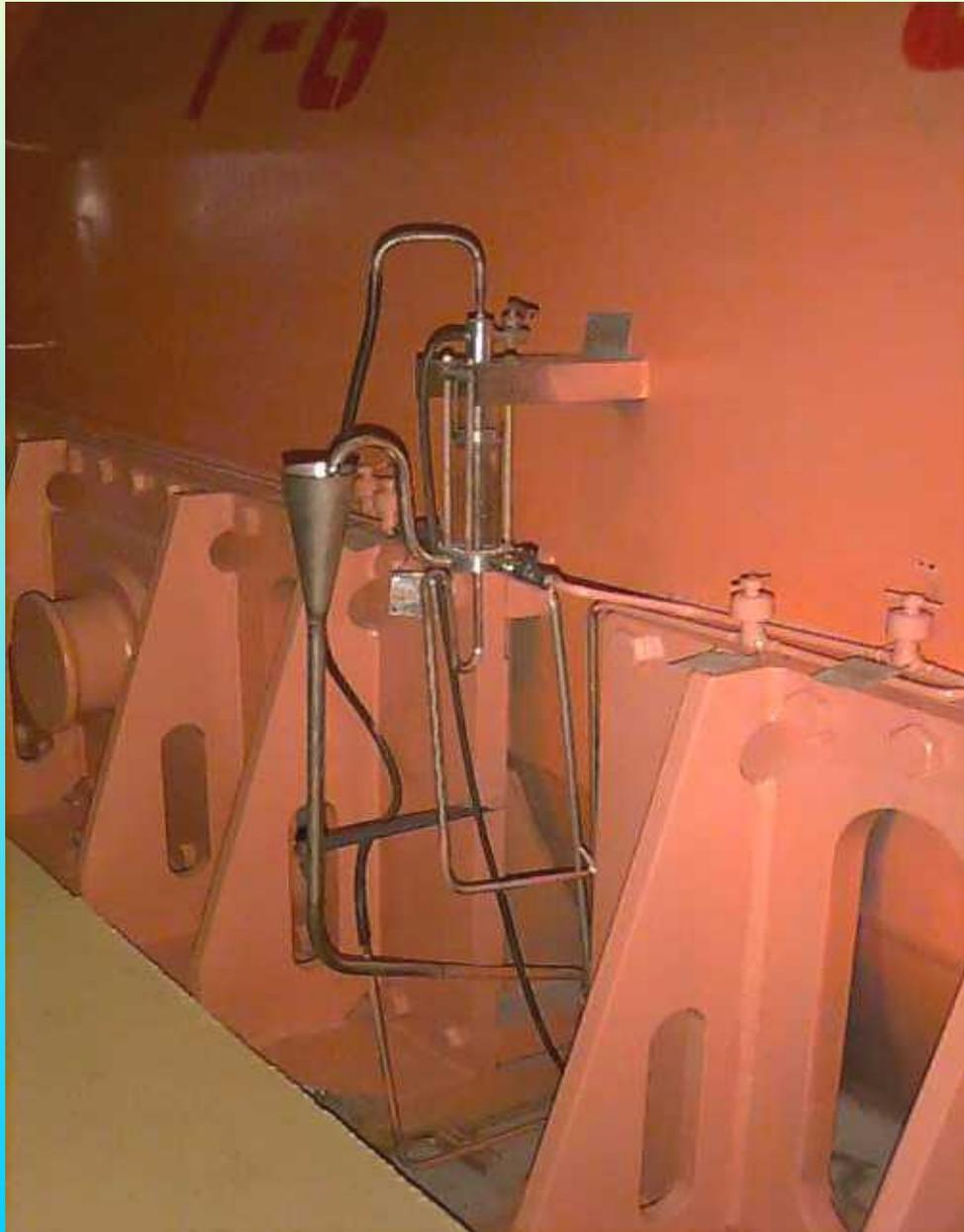
Газовая ловушка предназначена для отделения, накопления и контроля содержания водорода, проникшего в дистиллят из-за нарушения герметичности обмотки статора при давлении водорода внутри корпуса больше, чем давление дистиллята в обмотке статора.
