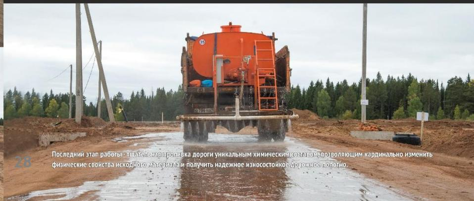
Последний этап работы – тщательная пропитка дороги уникальным химическим составом, позволяющим кардинально изменить физические свойства исходного материала и получить надежное износостойкое дорожное полотно.
