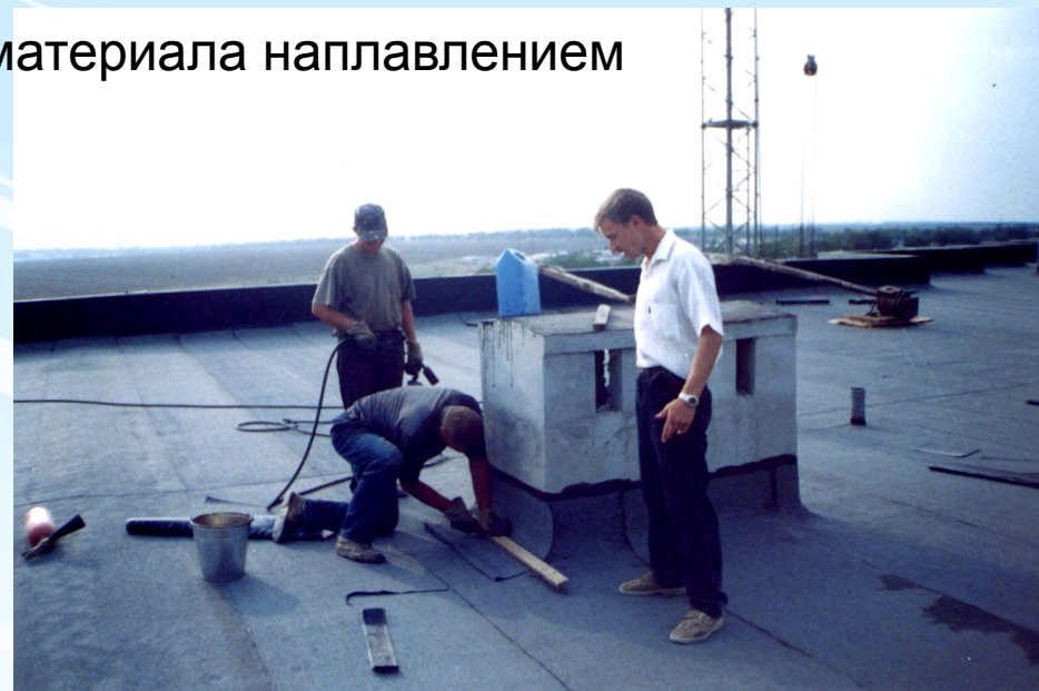
Устройство примыканий к вертикальным поверхностям
