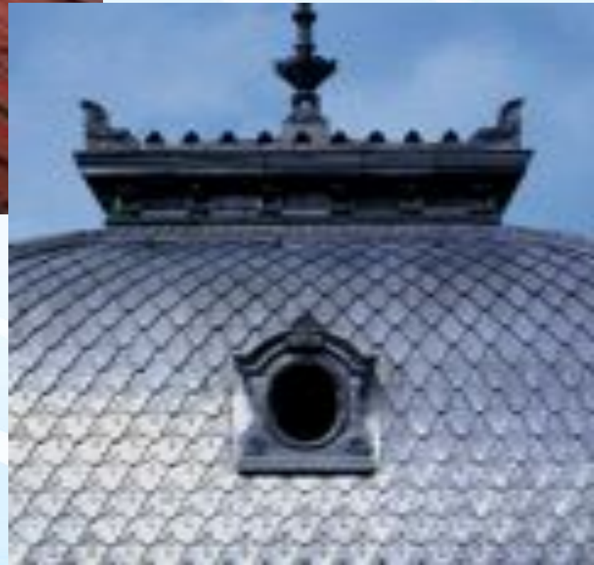
Кровля из титано-цинковой черепицы.
