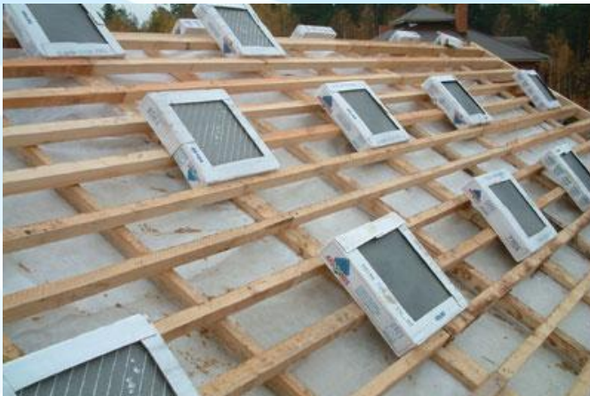
Установка обрешетки с заданным шагом.
