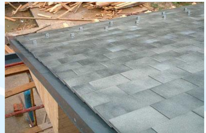
Монтаж плиток формата 25x40 со стороны торцевой планки
