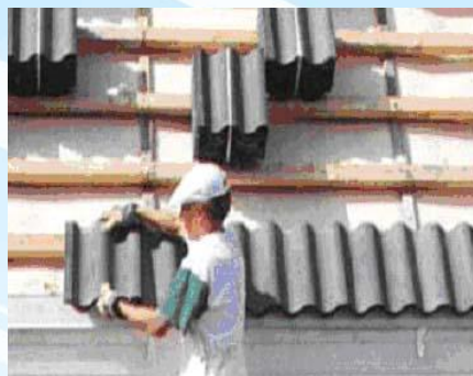
Укладка черепицы на обрешетку
