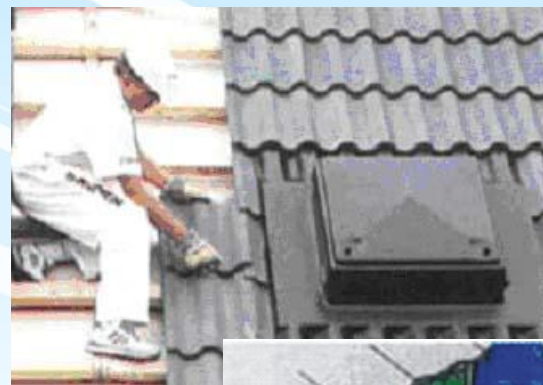
Примыкание черепицы к вентиляционному люку
