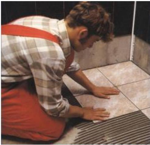
Принципы укладки напольных керамических и других плиток на пол, такие же как при укладке стеновых керамических плиток. Укладку напольных плиток начинаем от наиболее заметного угла в помещении
