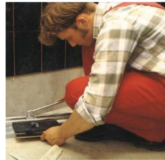
Обрезку плиток, следует выполнять при помощи специальных инструментов. Обрезанные плитки в углах и на откосах приклеиваем отдельно, в последнюю очередь.
