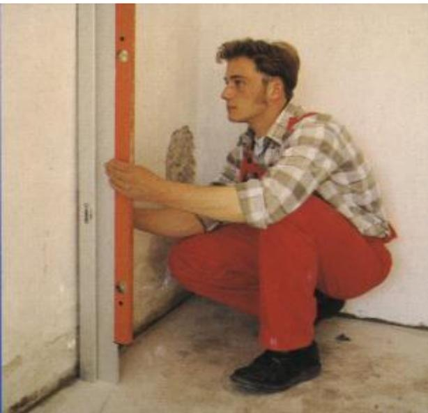
Очистка и выравнивание поверхности. Прикладывая рейку длиной 2м проверяются все отклонения стены от вертикали. Отклонения от рейки более 5мм должны быть устранены.
