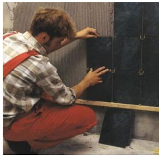
Укладку плиток начинают снизу. Чтобы швы были одинаковые, применяем дистанционные крестики, подбирая их до ширины шва. Плитки, после укладки на стене прижимают рукой, а если плитки большие - подбивают их специальным резиновым молотком. Излишки раствора удаляем, пока он не затвердел. Чтобы правильно приклеить плитку, клеевой раствор должен быть нанесён на всю поверхность плитки.
