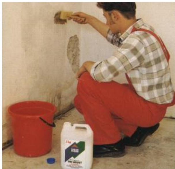
Грунтовочную эмульсию равномерно наносят на основание, кистью или малярным валиком.
