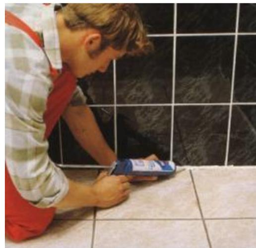
Соединение между стеной и полом силиконовой массой
