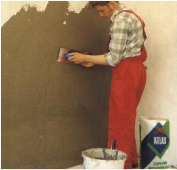
После затвердения первого слоя выравнивающего раствора, можно наносить следующий слой.
