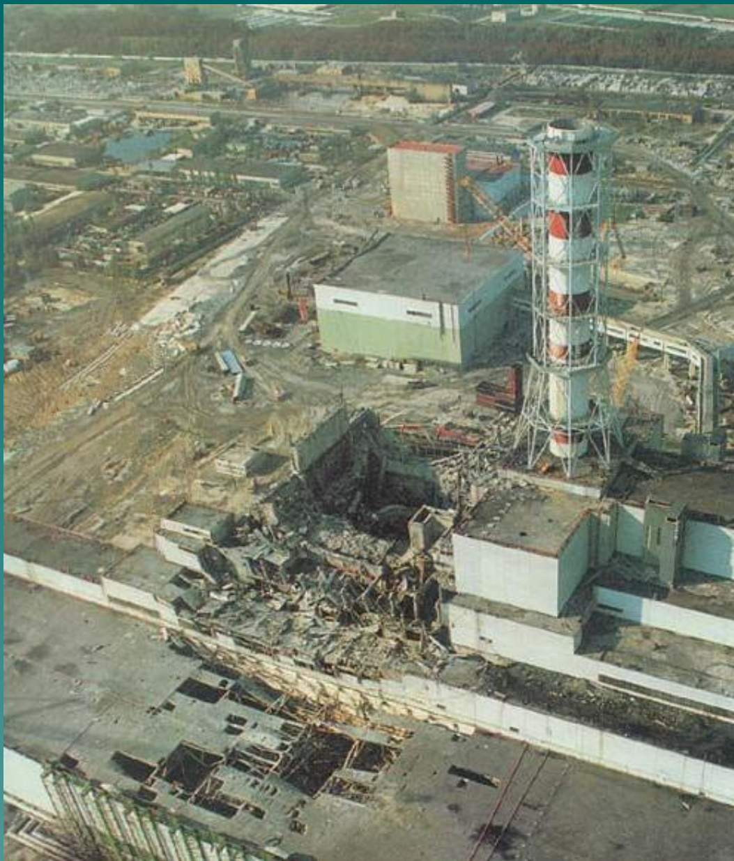
Чернобыльская АЭС после взрыва
