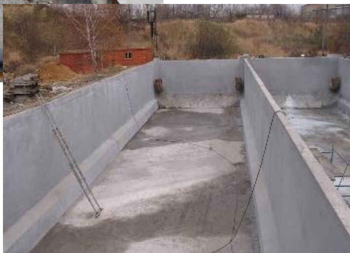
Восстановление железобетона перегородок
