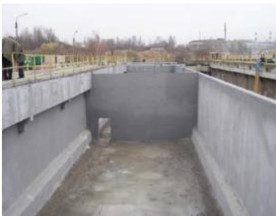
Внешний вид аэротенка после ремонта
