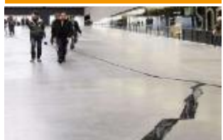
Ремонт и защита
