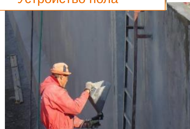
Нанесение гидроизоляции на перегородку
