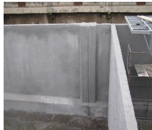
Вид деформационного шва разделительной стенки после ремонта
