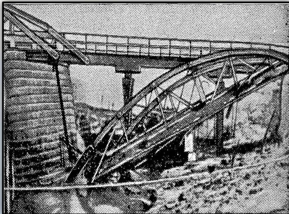
Типичный случай разрушения моста с просадкой и наклоном опоры (Япония 1923 г.)
