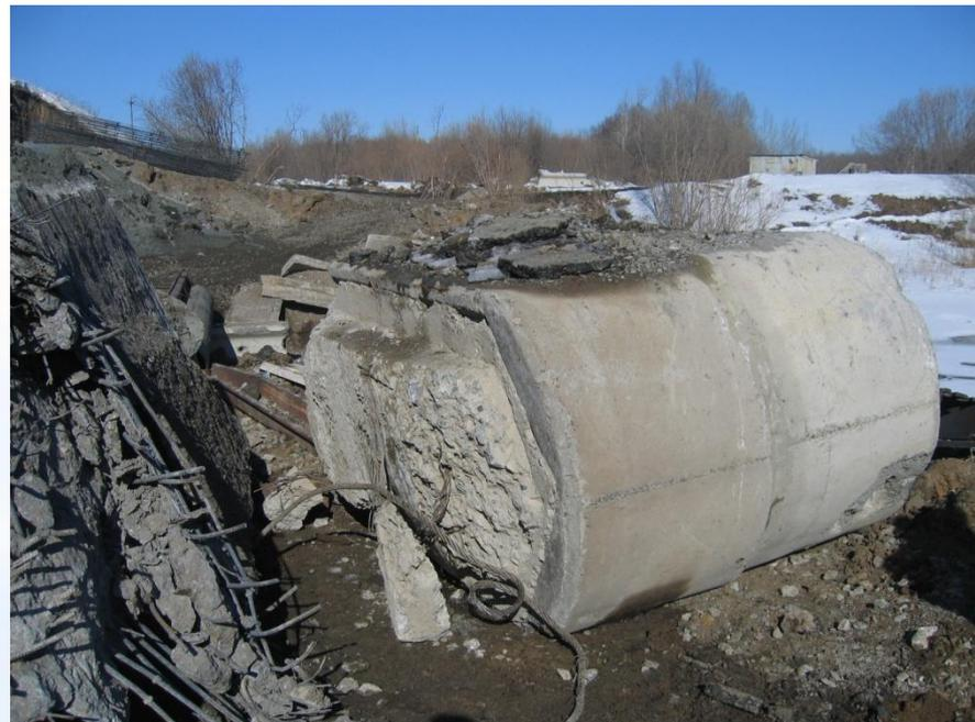
Обрушение железобетонного автомобильного моста
