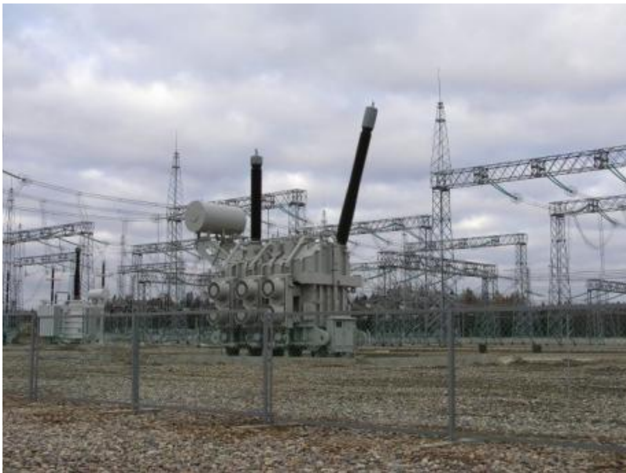
Однофазный АТ 750/500 кВ трехфазной группы 3x417 МВА
