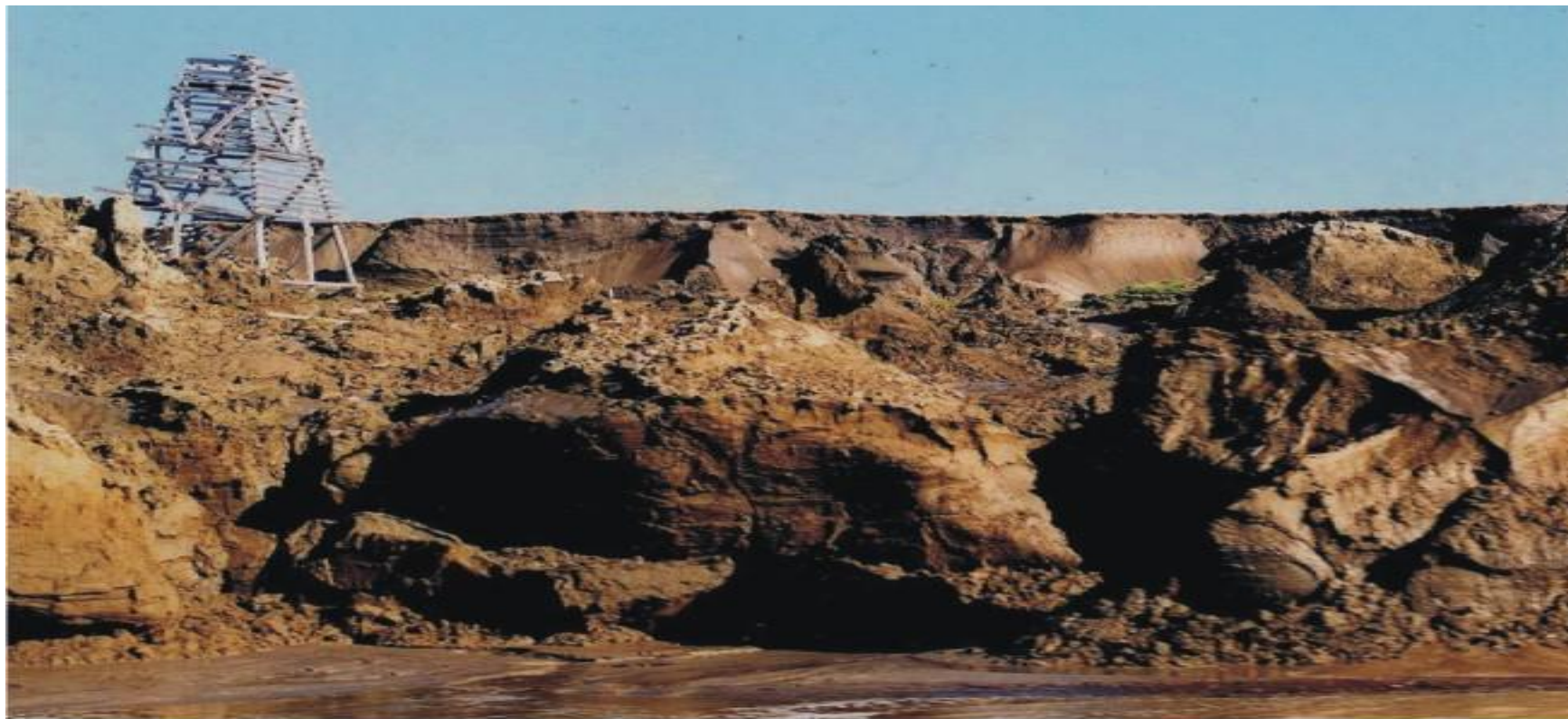
Рис. 7. Разрушающийся навигационный маяк, расположенный на льдистых береговых толщах (о. Большой Ляховский, пролив Дмитрия Лаптева).
