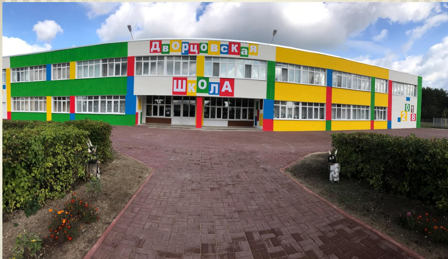
Ремонт фасада здания Дворцовой ООШ
