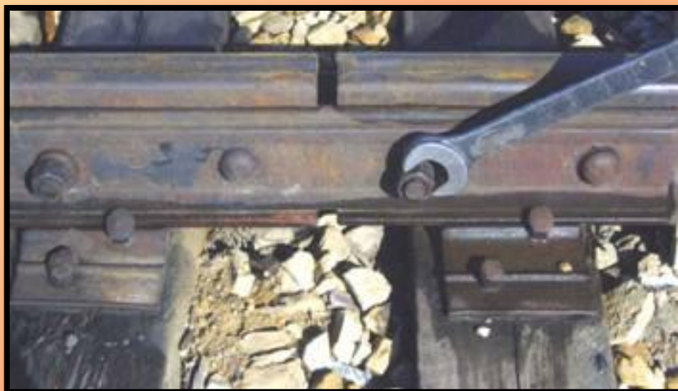
Двухголовые накладки к рельсам Р65 и Р75: 1 – соединяемые рельсы; 2 – накладка; 3 – болт с гайкой; 4 – болтовое отверстие
