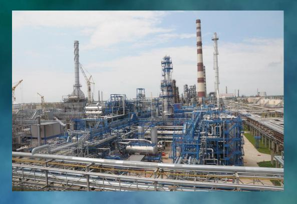
Установки ЛК-6У№1 и ЛК-6У№2 являются главенствующими установками на заводе по разгонке нефти. Дальше, разогнанные в колоннах фракции расходятся по секциям других установок для последующей переработки и получения товарной продукции. Все установки связаны между собой системой коллекторов.
