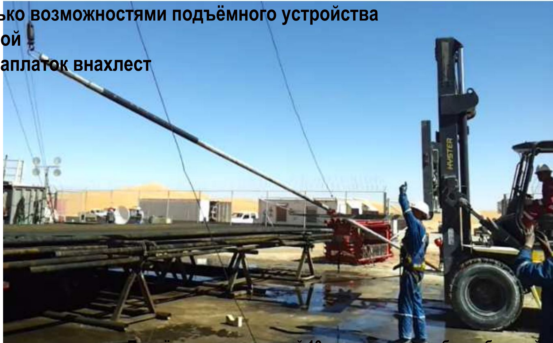
Подъём накладки длиной 13 м при помощи лебедки буровой
