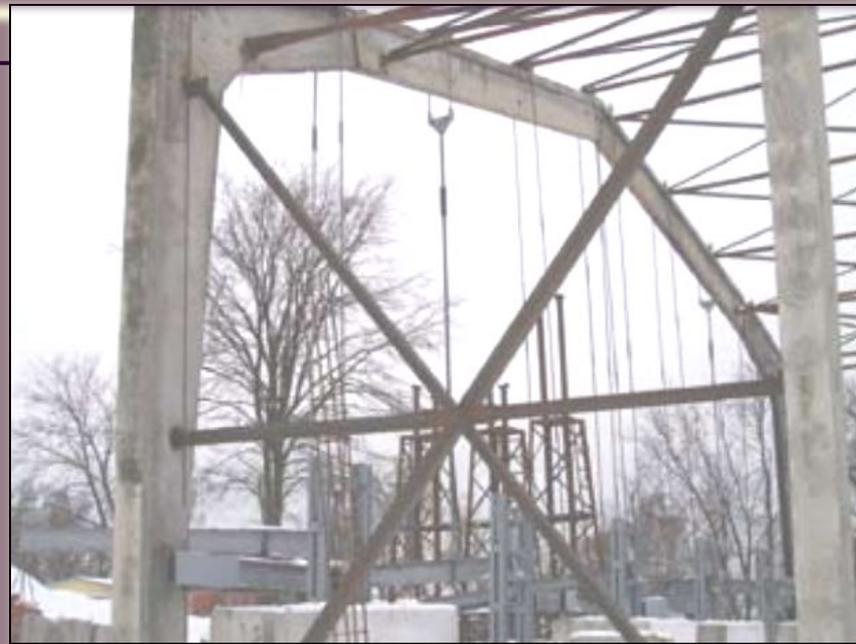
При устройстве покрытия необходимо обеспечить продольную жесткость всей конструкции путем:
