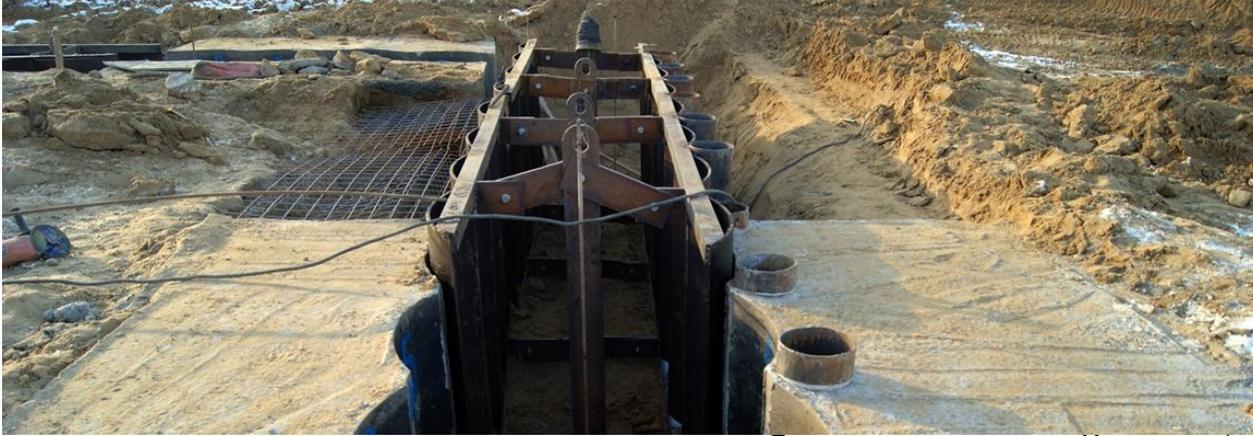
**Форшахта** – это предварительно устроенное железобетонное устройство, (направляющее устройство, или кондуктор, или воротник).
