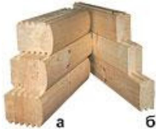
Образцы клееного бруса для возведения внешних (а) и внутренних (б) стен
