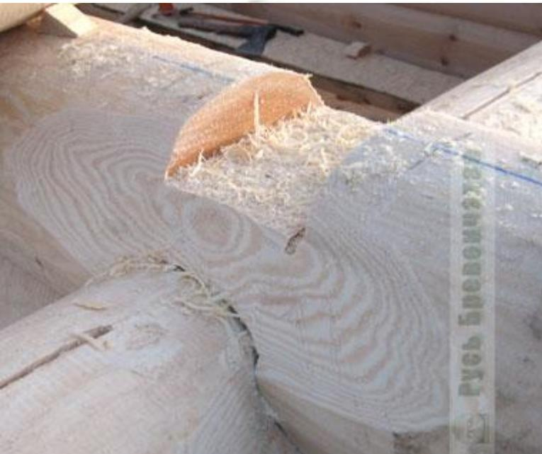
**паз в верхней части бревна предназначен для шипа.**
