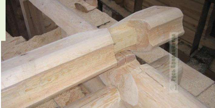
Шип (курдюк) и, соответственно, паз для него затруднительно сделать одним топором, здесь **нужна математическая ТОЧНОСТЬ.**
