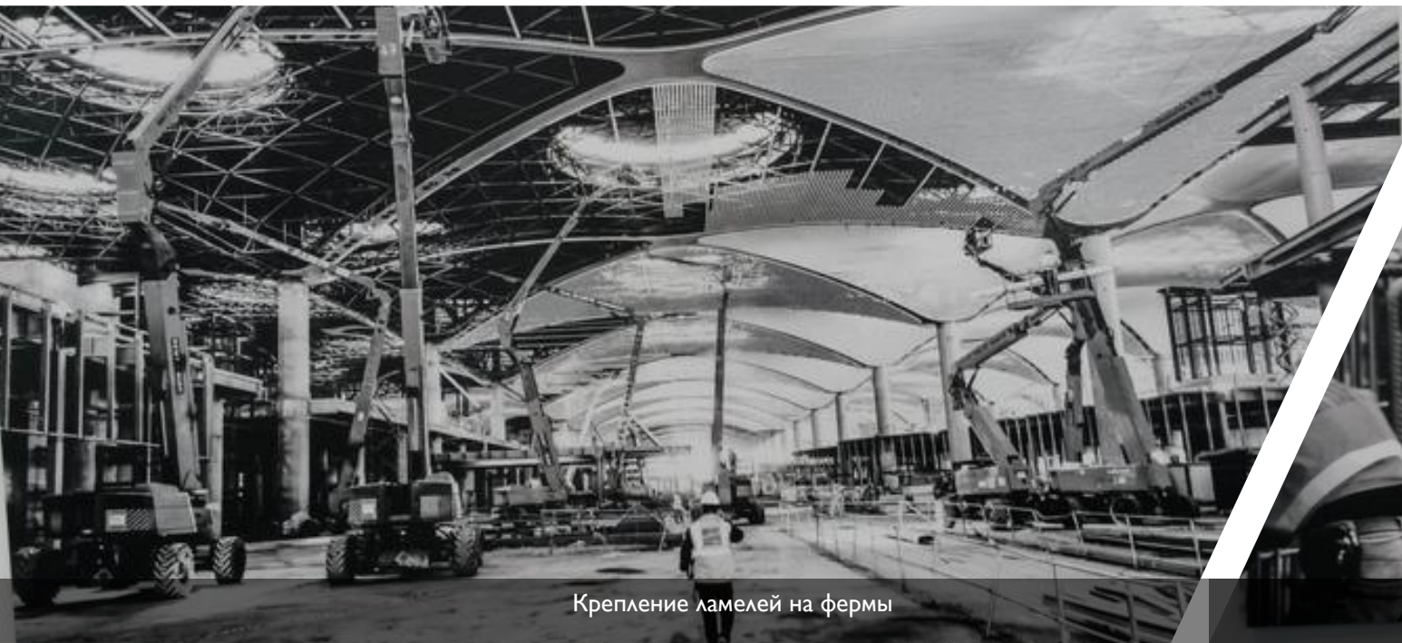
Монтаж светопрозрачных конструкций
