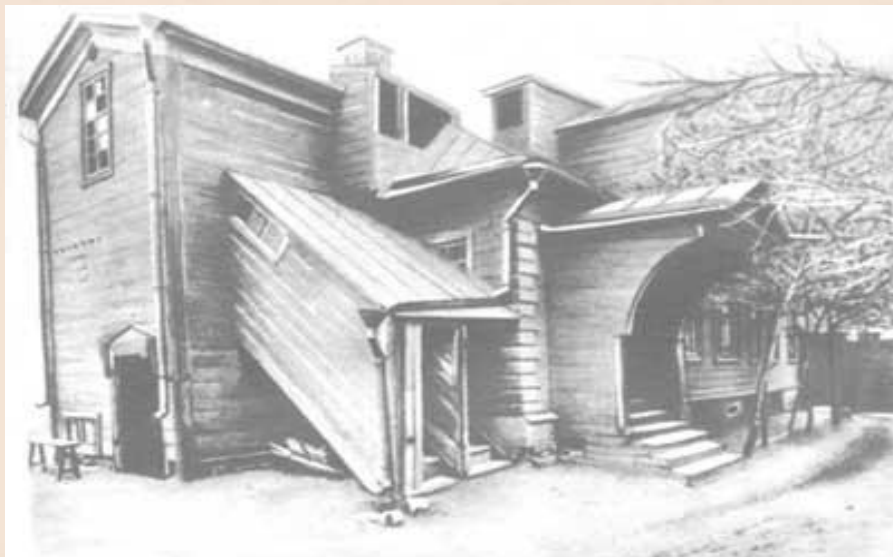
Дом Григорьевых в Замоскворечье. Малая Полянка, 12. Вид со двора. Фото 1915 г.
