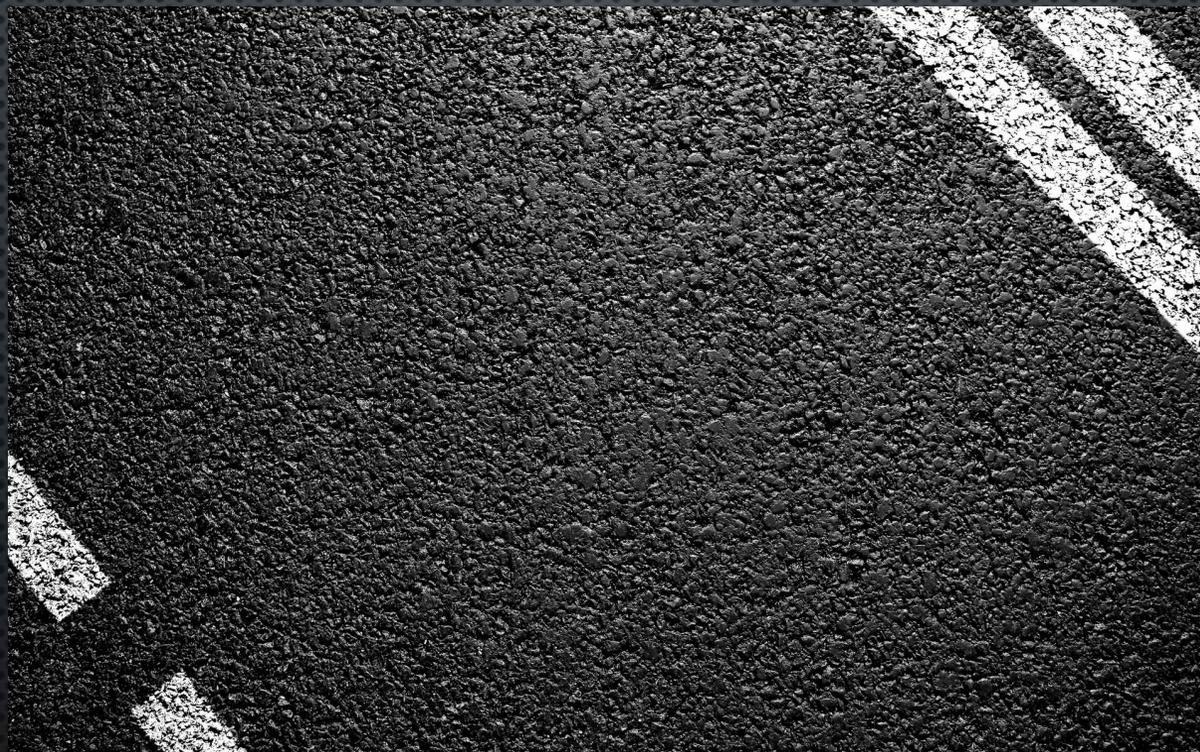
**Асфальтобетон** — искусственный строительный материал, полученный в результате уплотнения рационально подобранной и специально приготовленной смеси (асфальтобетонной смеси) минерального материала (щебня, песка, минерального порошка) и битума.
