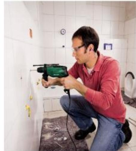
Сначала выбирают нужное по размеру дюбеля сверло, вставляют его в дрель и сверлят отверстие на требуемую глубину, соблюдая правила безопасности.
