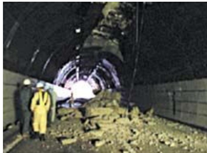
Рис. 2.14\*\*. Разрушение тоннелей после землетрясения
