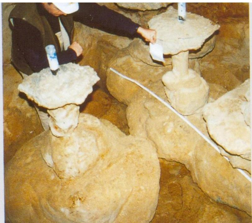
Вид грунтобетонного массива при углублении подвала здания
