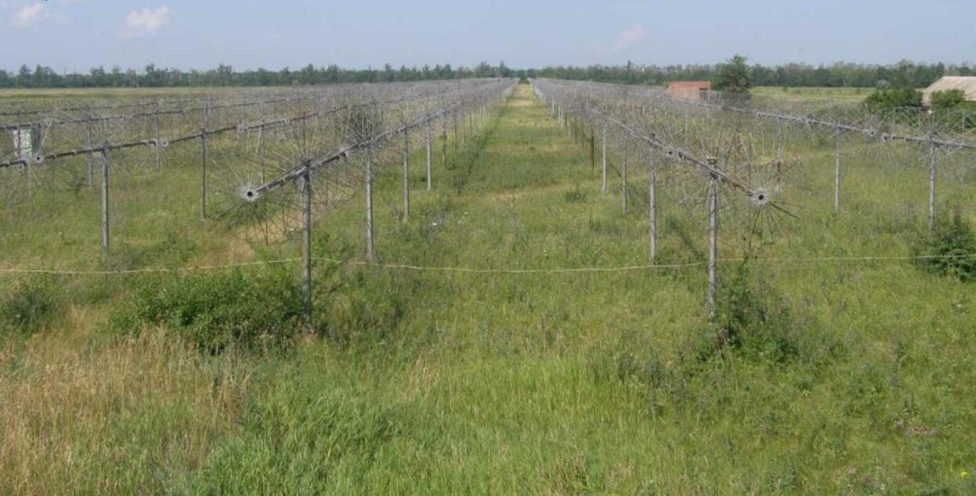
**«Диапазонный» крестообразный радиотелескоп (ДКР-1000) - назван из-за возможности проводить одновременные наблюдения в диапазоне частот от 30 до 120 МГц (2.5-10 м). Рефлектор антенны Восток - Запад был образован из продольных проволок (диаметр 2 мм и расстояние между ними -10 см), проложенных по 37 легким параболическим фермам (вес фермы - 1200 кг).**
