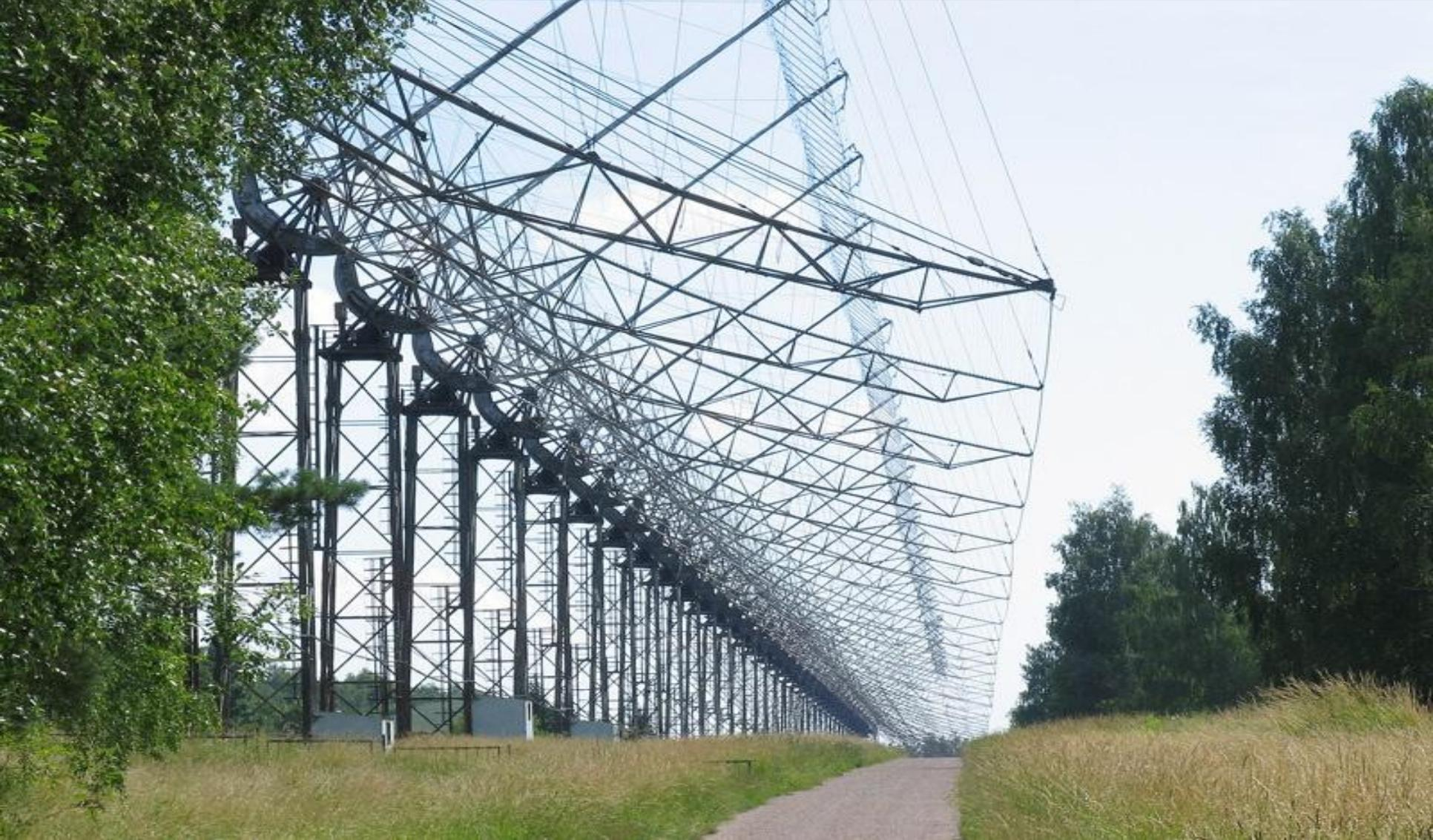
Круговой отражатель -895 прямоугольных отражающих элементов (11.4 x 2 м).
