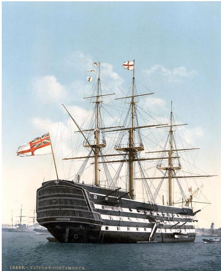
Класс парусных деревянных военных кораблей. Парусные линейные корабли характеризовались следующими особенностями: полным водоизмещением от 500 до 5500 тонн, вооружением, включающим от 30—50 до 135 орудий в бортовых портах, численность экипажа составляла от 300 до 800 человек при полном укомплектовании. Линейные корабли строились и применялись с XVII века и до начала 1860-х годов для морских боёв
