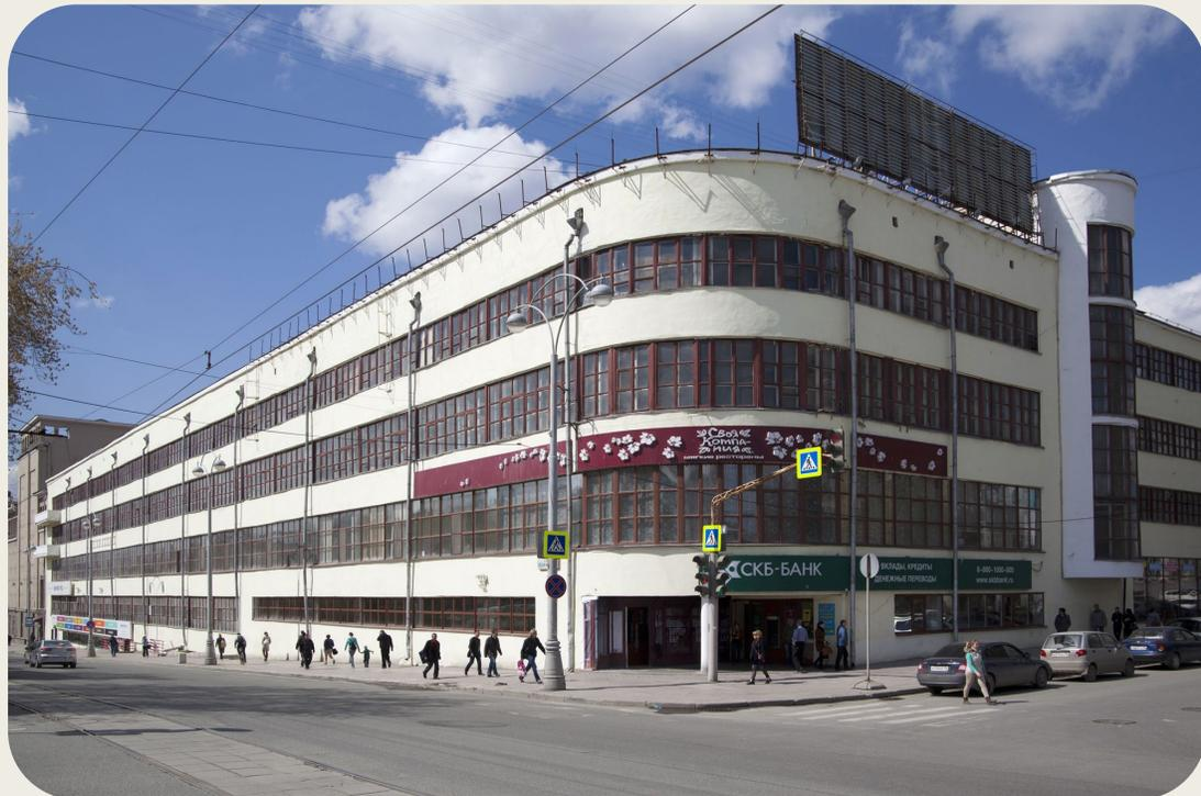
Определяющим архитектурным мотивом всех фасадов являются ленточные окна на гладкой поверхности стен. На восточном фасаде горизонтали ленточных окон разрываются остекленным эркером лестничной клетки, начинающимся со второго этажа. Другие фасады архитектурных акцентов не имеют. Главный фасад отличается гармоничностью построения и деловой представительностью. Архитектура фасадов определена системой конструкций. Здание имеет железобетонный каркас.
