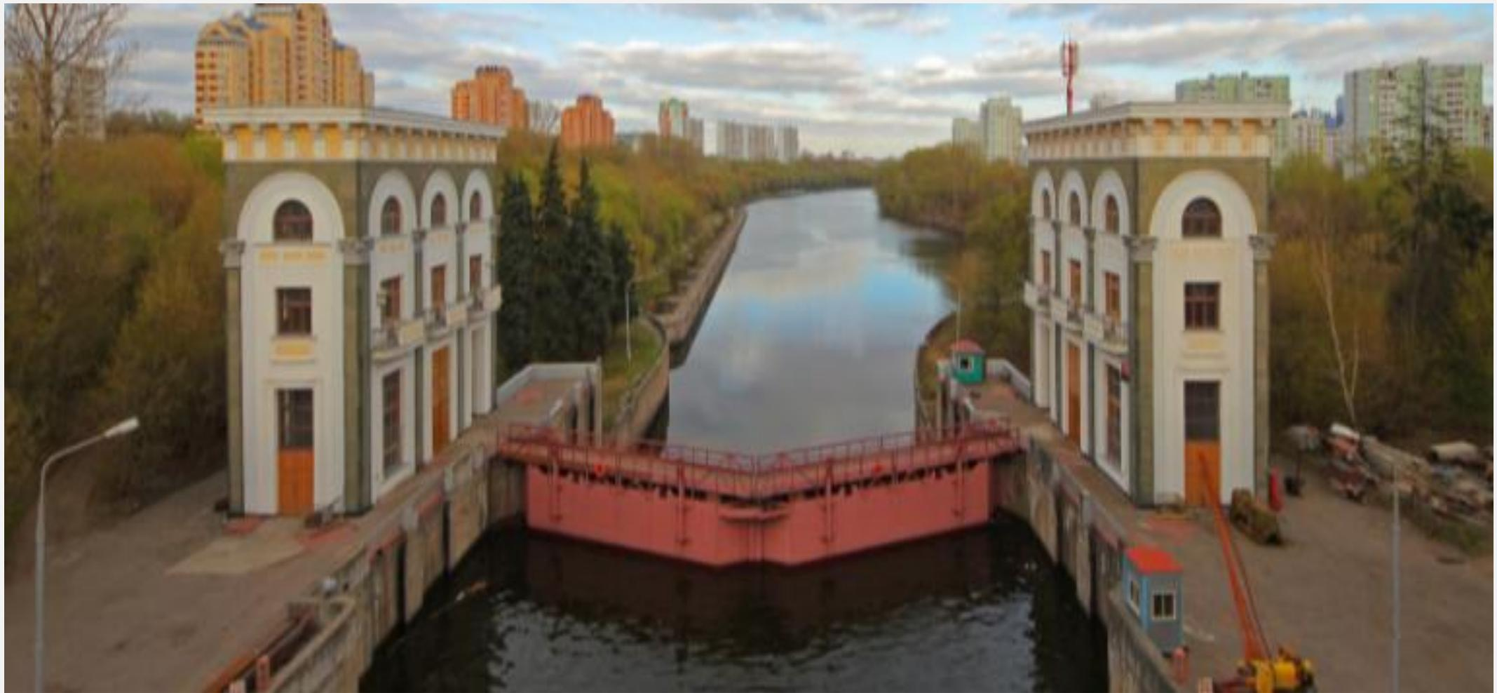
***Судоходный шлюз*** — гидротехническое сооружение на водных путях для обеспечения перехода судов из одного водного бассейна в другой с различными уровнями воды в них.
