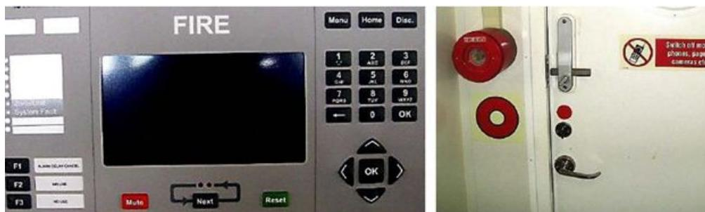
Контейнер со схемами противопожарной защиты судна
