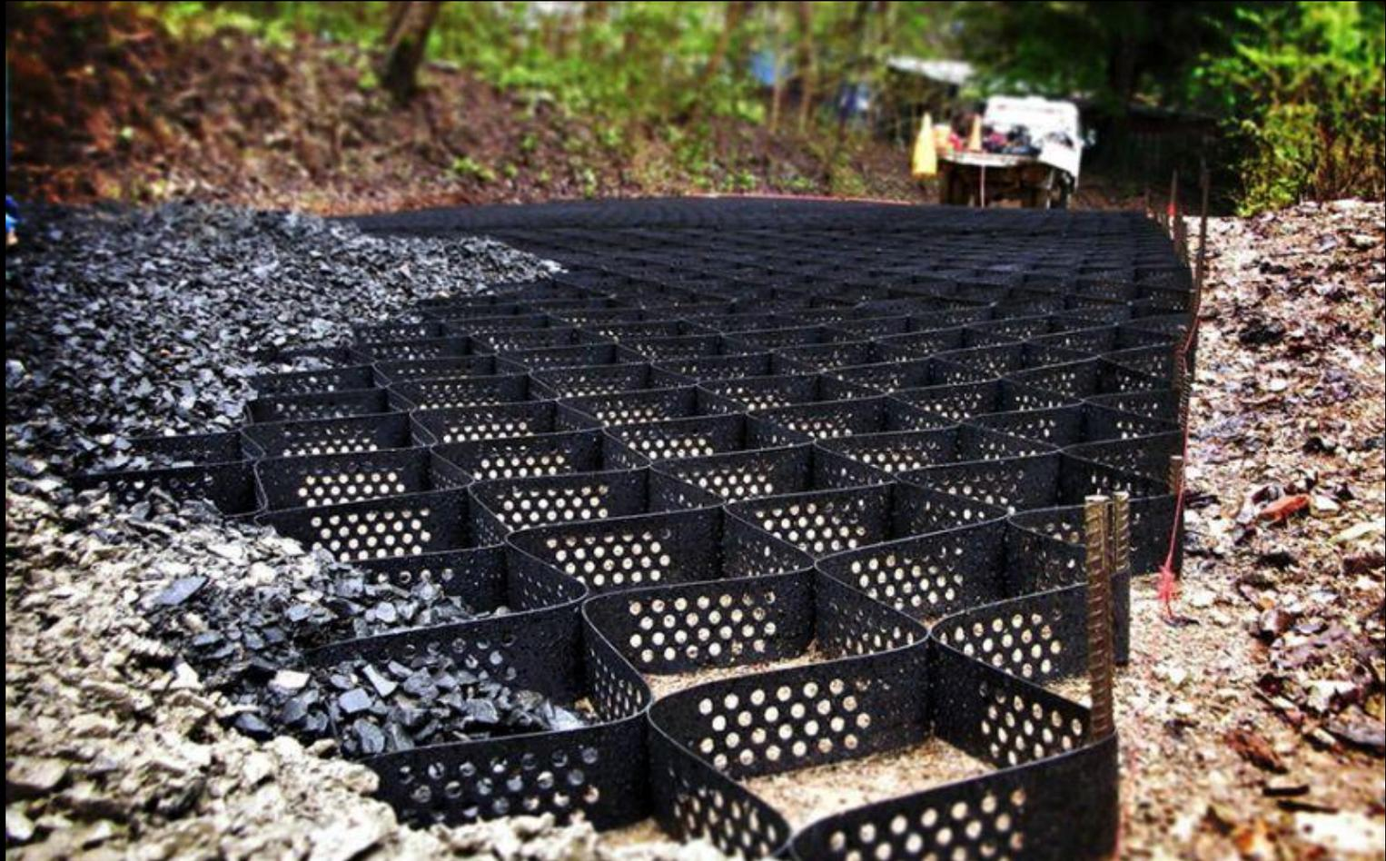
При строительстве дорожного покрытия может быть использована и плоская георешетка, которая не только стабилизирует и армирует дорожное покрытие, но и служит разделителем для инертных слоев. Благодаря конструкции данный тип георешетки способен выдержать высокий уровень нагрузок.
