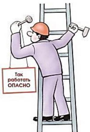
Приставные и свободностоящие лестницы высотой более 5 м, устанавливаемые под углом более  $75^\circ$  к горизонту, должны иметь, начиная с высоты 2 м от ее нижнего конца, дуговое ограждение или должны быть, оборудованы канатом с ловителем для закрепления карабина предохранительного пояса, а устанавливаемые под углом от  $70^\circ$  до  $75^\circ$  к горизонту - перильное ограждение с обеих сторон с высотой по вертикали от 0,9 до 1,4 м, начиная с высоты 5 м.
